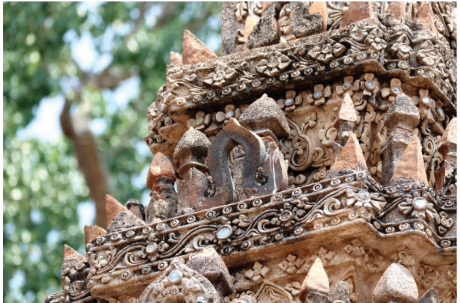
ภาพที่ 77 งานเครื่องปั้นดินเผาประดับชุ่มประตู่โขง วัดป่าคันหลวง เป็นโกลนก่อนที่จะปั้นปูนทับอีกครั้ง
