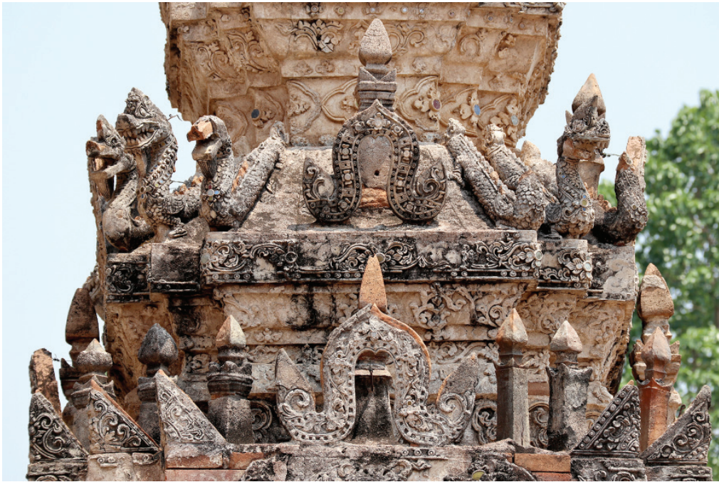
ภาพที่ 75 การโคลนลายด้วยเครื่องปั้นดินเผา ก่อนใช้เทคนิคปูนปั้นประดับลวดลายอีกครั้ง
