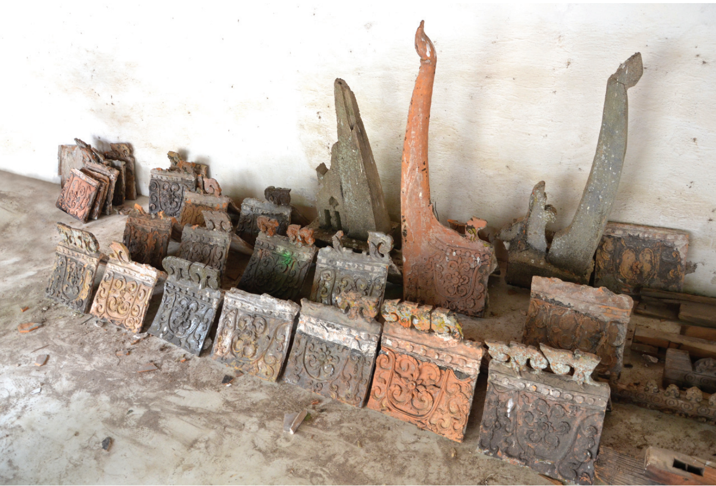
เครื่องเคลือบดินเผา ซ่อฟ้า ปราสาทเพ็ญ เมฆตั้งเมฆไหล เครื่องบนวิหารน้ำแต้ม วัดพระธาตุลำปางหลวง อำเภอกะเคา จังหวัดลำปาง การบูรณะครั้งใหญ่ในปี พ.ศ. 2554 โดยกรมศิลปากร
