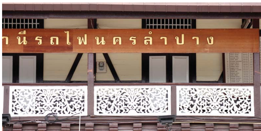
ภาพที่ 243 สถานีรถไฟนครลำปาง อำเภอเมือง จังหวัดลำปาง
