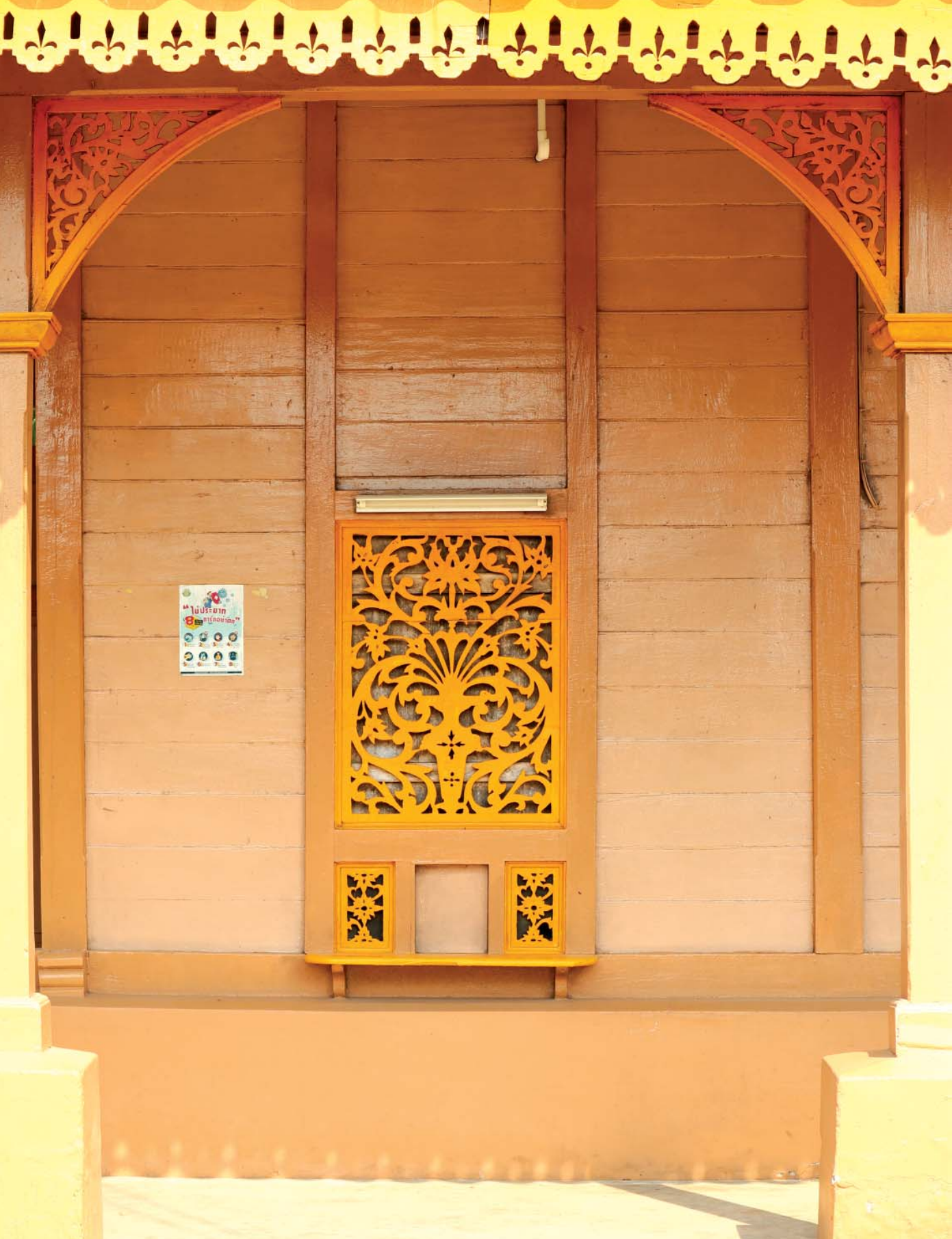
ลายหม้อดอก เทคนิคงานฉลุไม้ ประดับห้องจำหน่ายตู้รวมไฟ สถานีรถไฟปางป๋วย อำเภอแม่ทะ จังหวัดลำปาง
