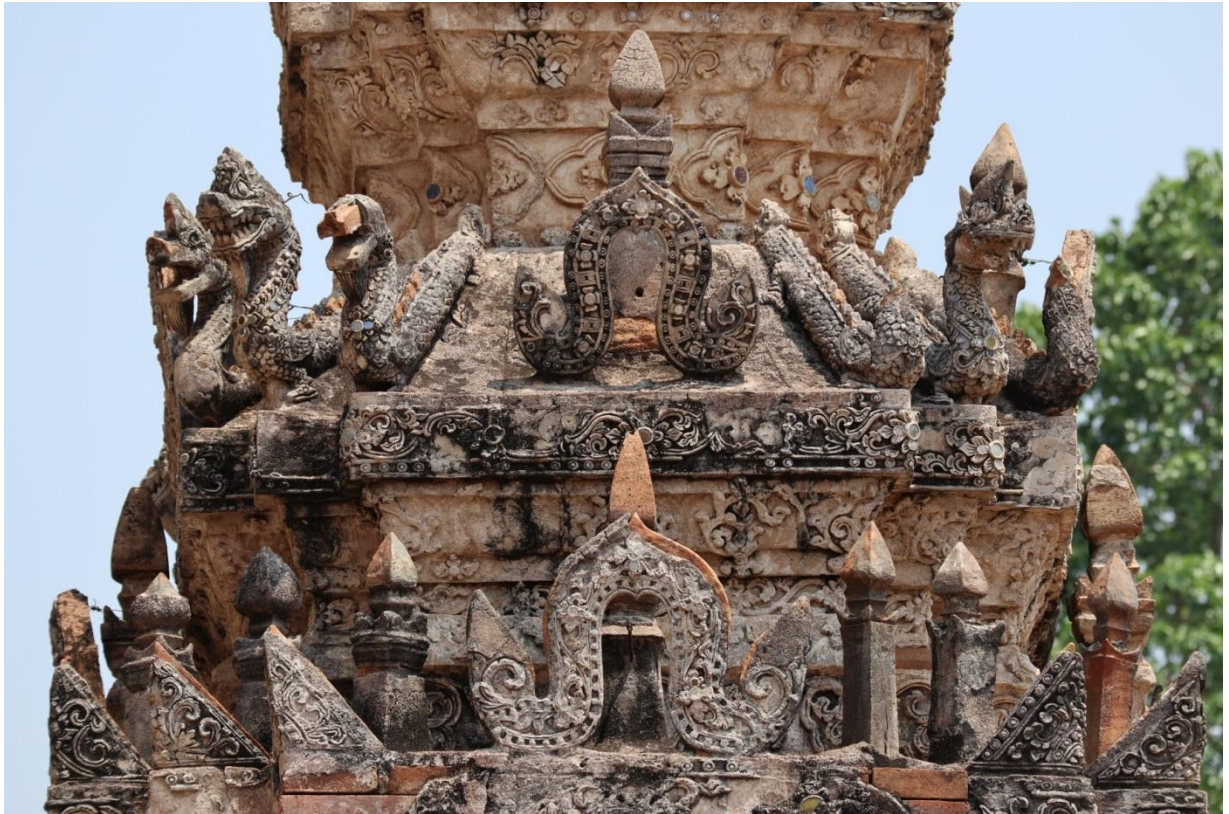
ภาพที่ 58 การโคลนลายด้วยเครื่องปั้นดินเผา ก่อนใช้เทคนิคปูนปั้นประดับลวดลายอีกครั้ง
