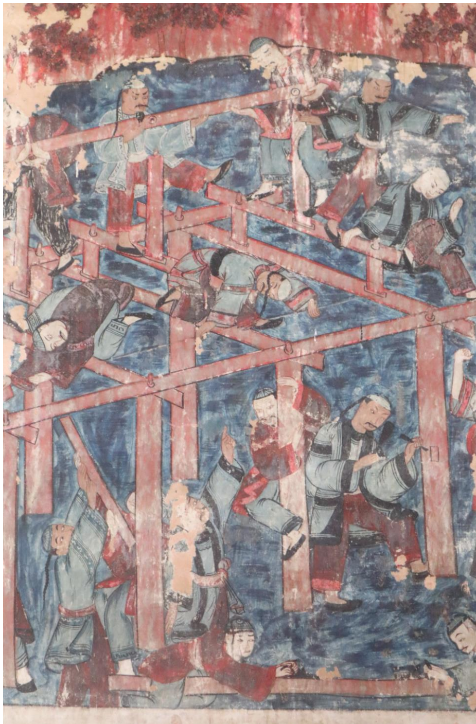
ภาพที่ 70 ภาพช่างชาวจีนที่มาทำการก่อสร้างอาคารด้วยการเข้าไม้มาต่างใหม่
